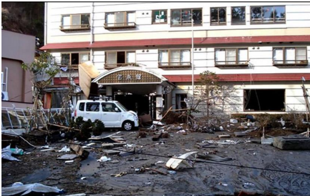
宝来館は 2 階まで津波被害を受けた
