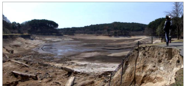
貯水池には水は無く、乾いた大地が広がる藤沼ダムの決壊現場
