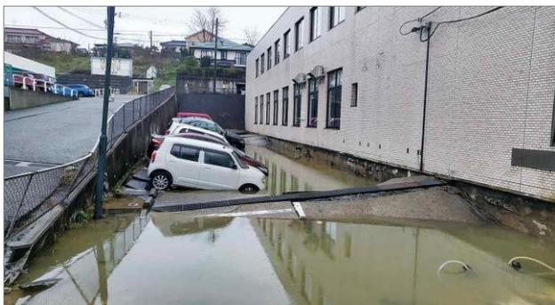
地震での液状化により、陥没した新潟西郵便局駐車場
