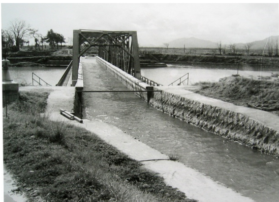
完成直後の西川水路橋 提供:青池 国政氏
