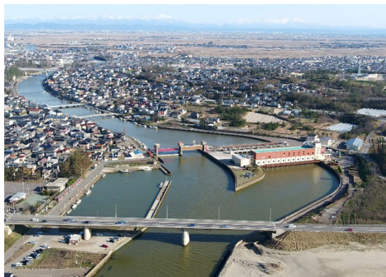
昭和 47 年完成の新川河口排水機場 撮影：王 毅
