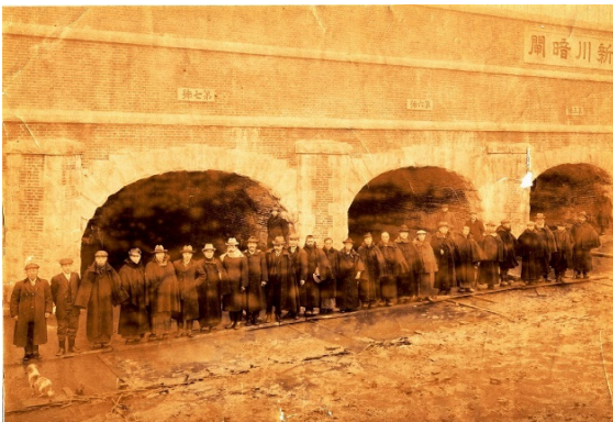
完成直後の新川暗閘 出典:西蒲原土地改良区所蔵
