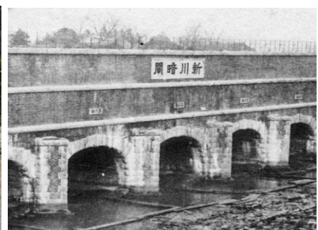
完成直後の新川暗閘 上流部の銘板
