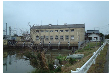
改修工事中新川右岸排水機場
