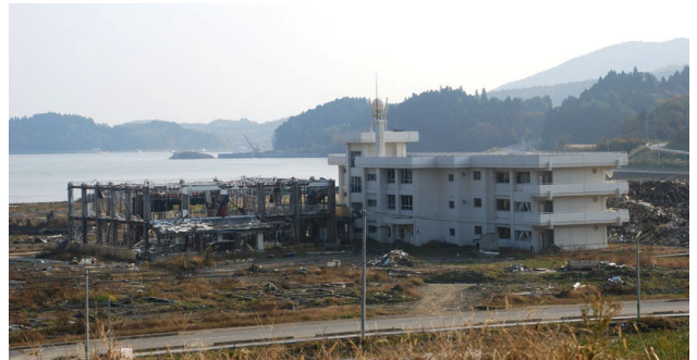
完成10日で鉄骨だけとなった体育館と、戸倉小学校校舎
