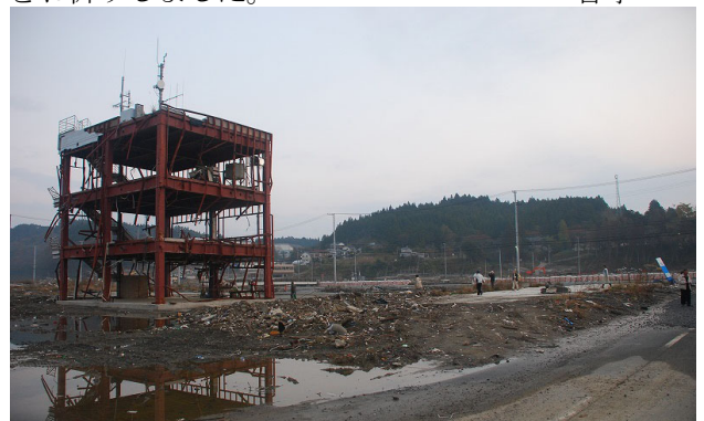
鉄骨だけが残る南三陸町防災対策庁舎
