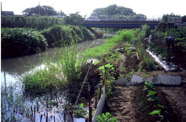
西川の護岸工事予定場所
