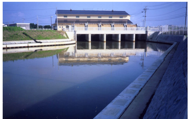
新装になった新川右岸排水機場
