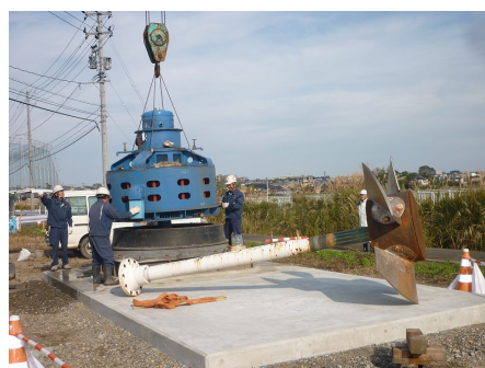
ポンプ設置中
