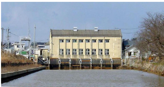
旧新川右岸排水機場(ポンプ5台)
