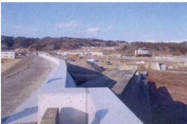
復旧中の防潮堤
