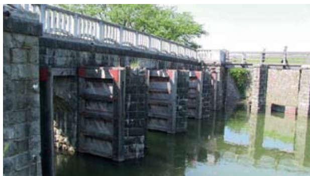
土木学会選奨土木遺産の土砂吐水門と運河水門
