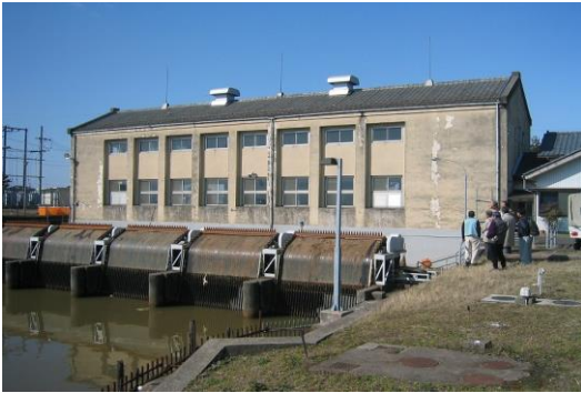
昭和 28 年から稼働の新川右岸排水機場外観 撮影：加藤
