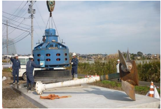
ポンプ1基とシャフトを据え付け 撮影：山岸
