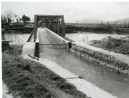
昭和 30 年完成直後の西川水路橋 提供：青池 国政氏
