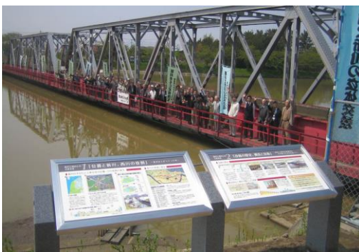
水路橋を望む新川沿いに設置した案内板 撮影：加藤
