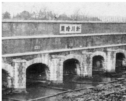
完成直後の新川暗閘写真を拡大 出典：新潟県『西川改良及新川底樋改造工事報文』
