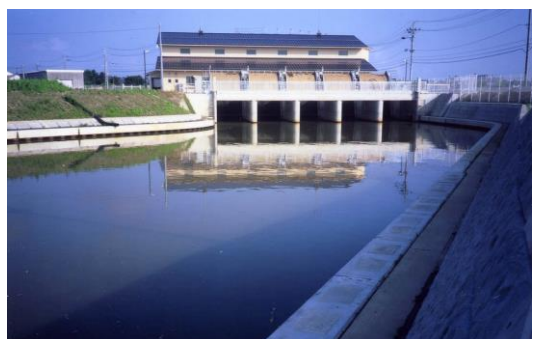
平成 24 年 7 月稼働の新川右岸排水機場 撮影：佐藤
