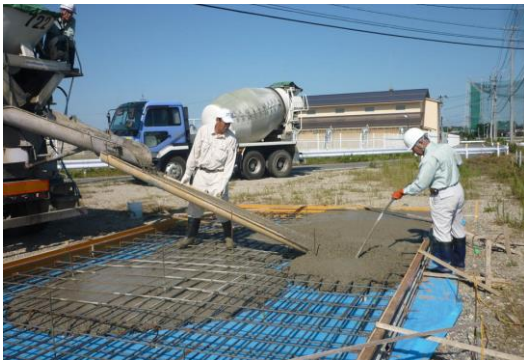
ポンプ台座のコンクリート打設 撮影：山岸
