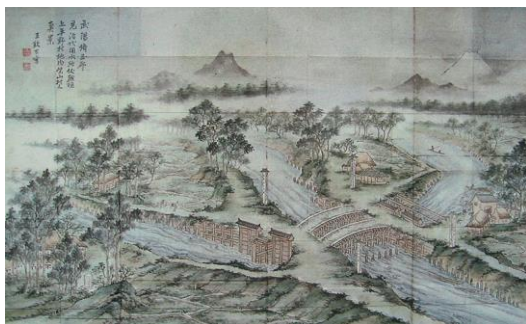
逆サイフォンを使用した柴山伏越の開設絵図 現地の説明板より 撮影：加藤
